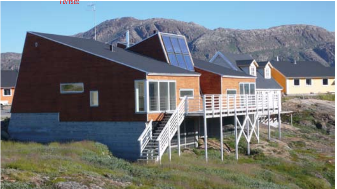
Et kig ind mod lavenergihuset i Sisimiut.
