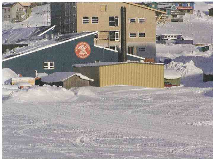
Et kig ind mod Bygge- og Anlægsskolen i Sisimiut, hvor årets arktiske konference blev holdt.
