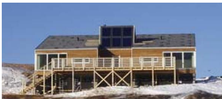
Plane solfangere på Lavenergihuset, Sisimiut
