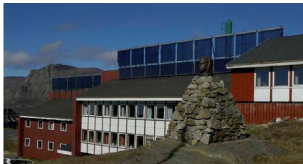
Vaccumrørs- og plane solfangere på Knud Rasmussens Højskole, Sisimiut
